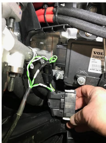
Final montiert / final installation
